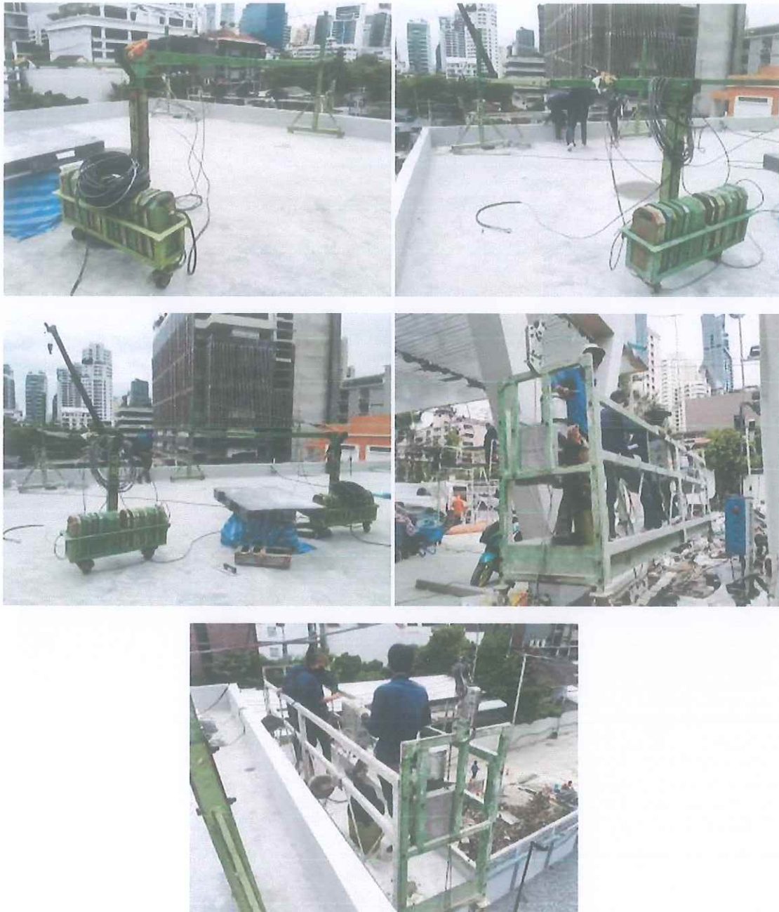
รูปแสดงการตรวจสอบทดสอบส่วนประกอบและอุปกรณ์กระเช้าไฟฟ้า
