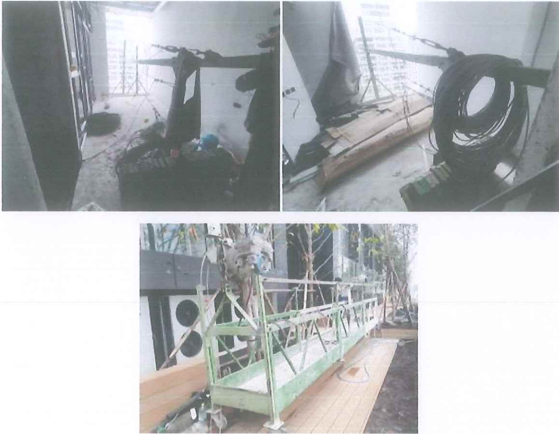
รูปแสดงการตรวจสอบทดสอบส่วนประกอบและอุปกรณ์กระเช้าไฟฟ้า
